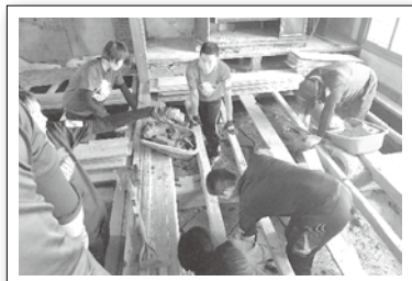
床下の土砂の掻き出しをしている様子
