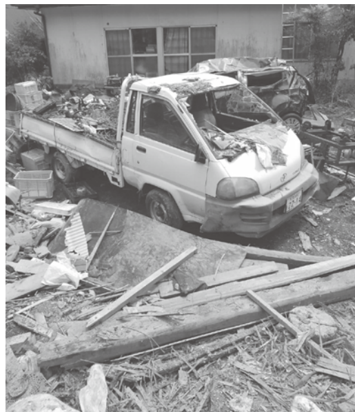
(芦北町の被災民家)
